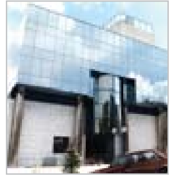
TBMM Eğitim ve Sosyal Hizmet Binası
