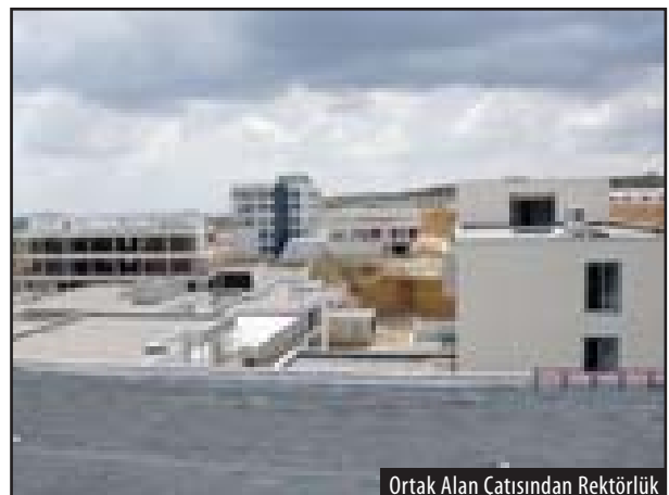
Ortak Alan Çatısından Rektörlük
