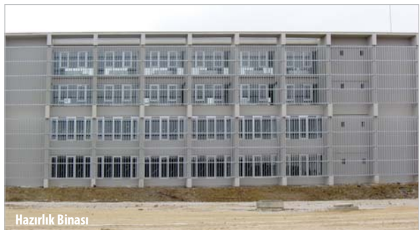
Hazırlık Binası Ön Cephe
